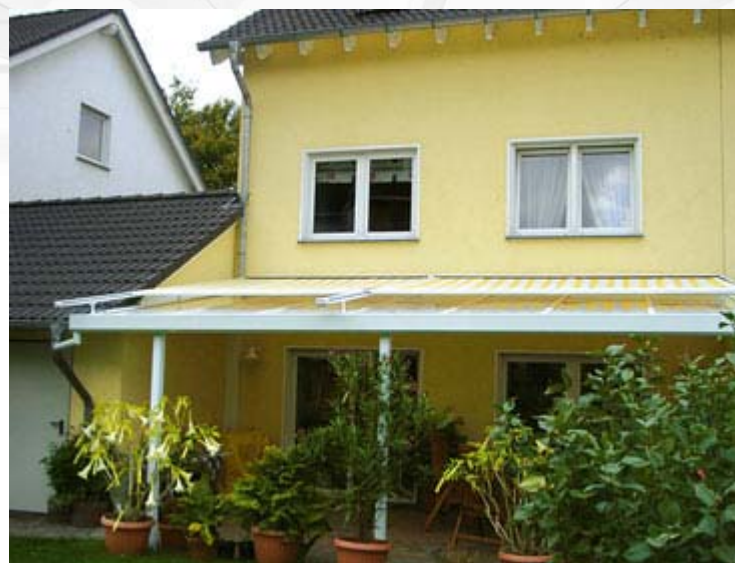
■ Terrassendach in RAL 9016 (verkehrsweiß) mit Eindeckung aus Polycarbonat in weißopal mit Außenbeschattung
